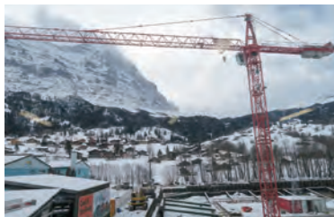
12月から運行開始(現在工事中)
