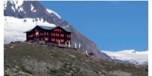
フルアルプ小屋 Berghütte Fluhalp
